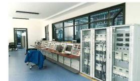
自动化泵站(DATA86)适用于城市供水系统中加压泵站的远程监控及管理。泵站管理人员可以在供水公司的泵站监控中心远程监测站内清水池水位或进站压力、加压泵组工作状态、出站流量、出站压力等;支持水泵启动设备手动控制、自动控制、远程控制加压泵组的启停;光纤通信时, 可以图像监视站内全景及重要工位, 实现泵站无人值守。
